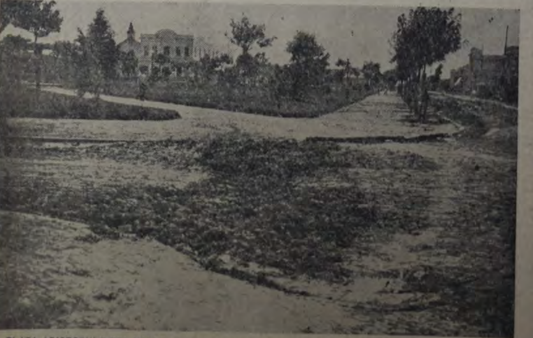
PLAZA ARISTOBULO DEL VALLE, ANGULO SOBRE LAS CALLES CAMPANA Y MARCOS SASTRE. EL enorme pozo que se ve en primer término y la calzada llena de basuras de la derecha, demuestran palpablemente la inconcebible negligencia del departamento ejecutivo municipal. Se trata del único lugar de expansión para las familias y los niños del centro de Villa del Parque. Así lo cuida la municipalidad!
